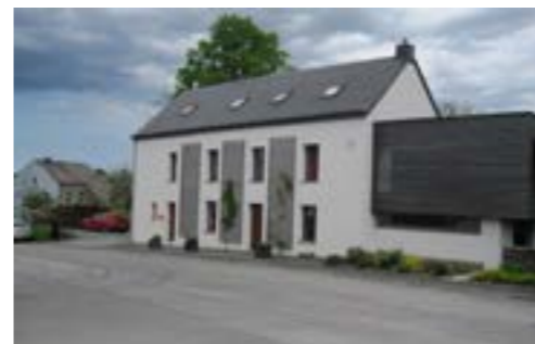
Annexe revêtue d'un bardage bois en contraste avec la couleur de l'enduit...
