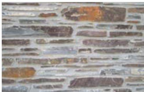
Une maçonnerie de pierre.
