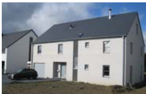
Un matériau de substitution.
