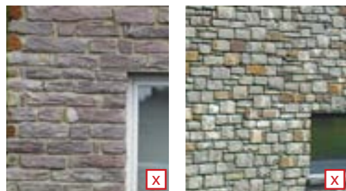
Parements dont la teinte et le format des moellons ne sont pas adaptés au contexte.
