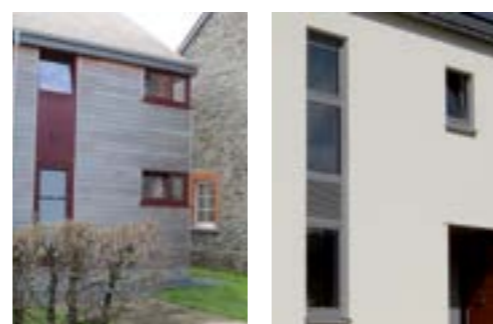
Touches de couleurs apportées par les menuiseries.
