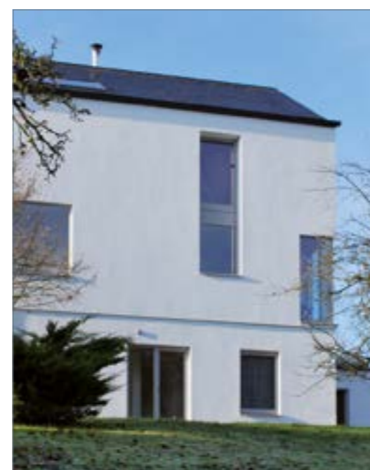
De nouvelles techniques constructives (enduit sur isolant).
