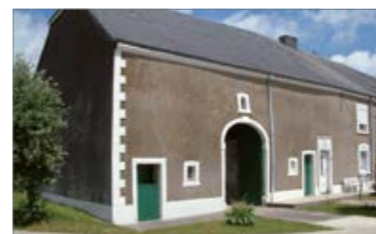
Les teintes sombres du ciment.
