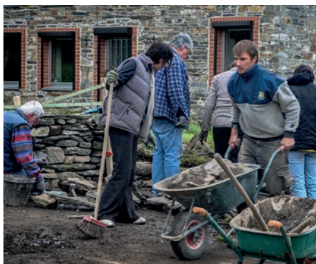
Restauration d'un mur en pierre sèche à Vielsalm.
