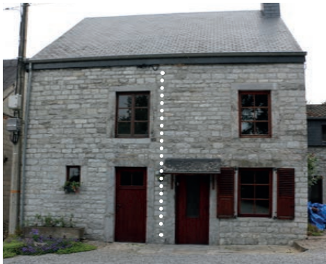
Une petite ferme alignant corps de logis et étable surmontée d'un fenil
