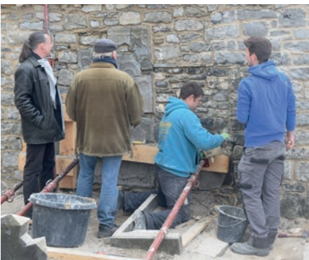
Restauration du mur de cimetière de Gerin (Onhaye) dans le cadre de l'appel à projet 16 + de l'Alliance Patrimoine Emploi.
