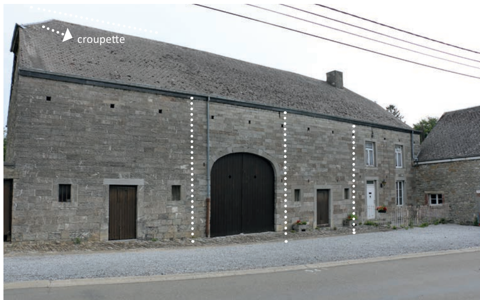
Une ferme quadricellulaire où se succèdent un corps de logis et deux étables enserrant une grange.
