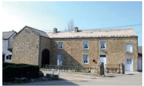
Un logis encadré par une étable surmontée d'un fenil à droite et une grange positionnée en retour d'équerre.
