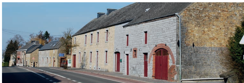
Une courte séquence de maisons jointives le long de la N921.
